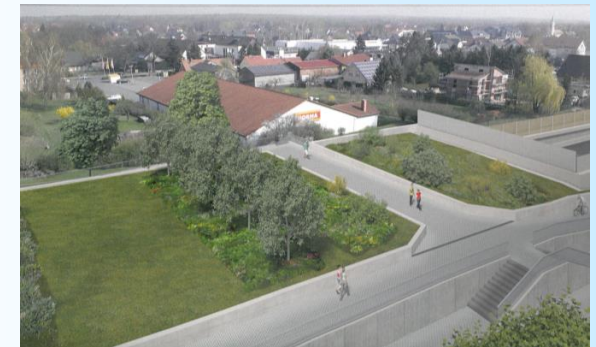
Bild 11: Blick von Klandorfer Str. 30 auf Tunnel
