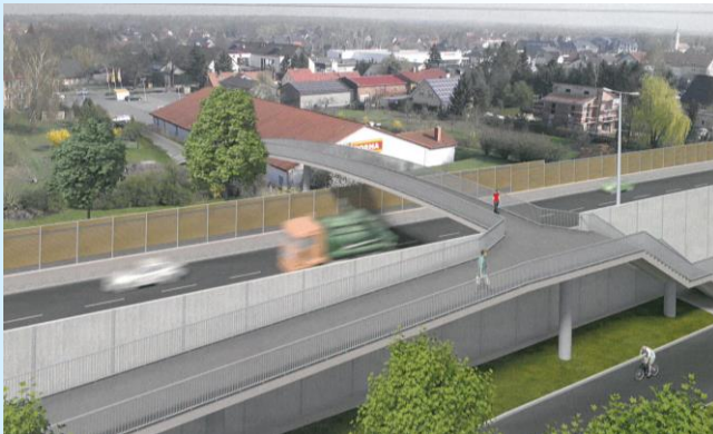
Bild1: Visualisierung ebenerdige Führung mit Lärmschutzwand
